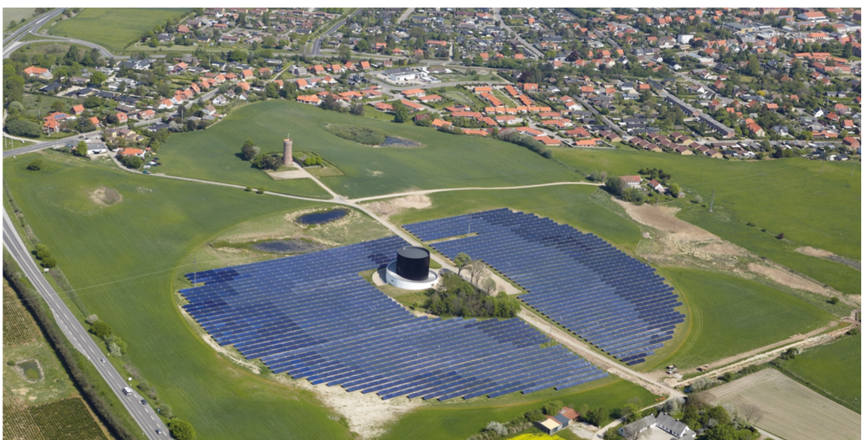
Rys. 2. Solarna wyspa ciepła wraz z akumulatorem ciepła Źródło: Arcon Sunmark, Forum Energii*
